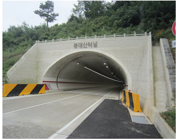
1공구 봉대산터널(서울) 종점부
