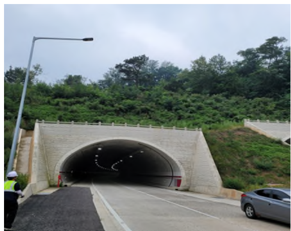
1공구 봉대산터널(문산) 종점부
