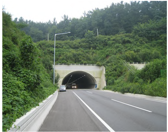
4공구 금촌터널(문산) 종점부
