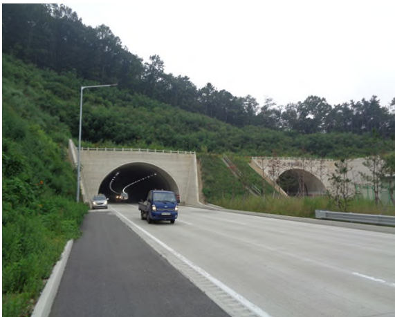
3공구 견달산터널(서울) 시점부
