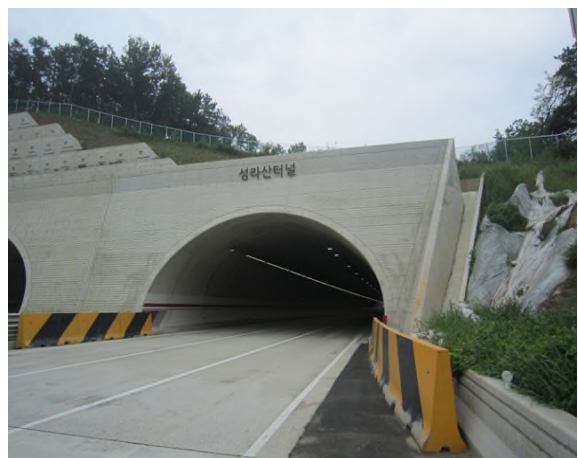
1공구 성라산터널(서울) 종점부
