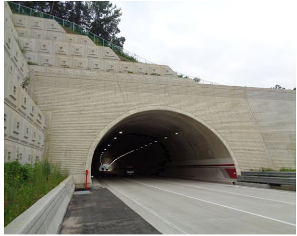
1공구 성라산터널(문산) 종점부
