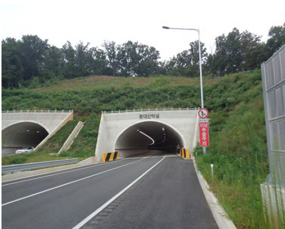
1공구 봉대산터널(문산) 시점부
