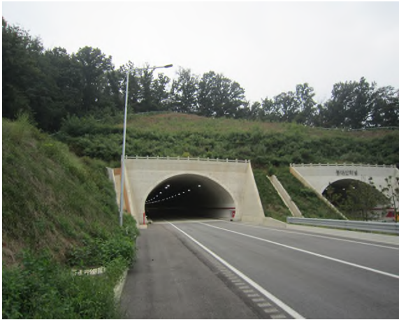
1공구 봉대산터널(서울) 시점부
