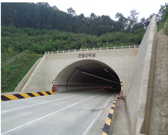
3공구 견달산터널(문산) 시점부
