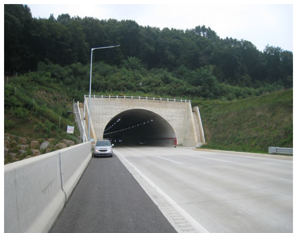
3공구 견달산터널(문산) 종점부
