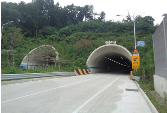
4공구 금촌터널(문산) 시점부
