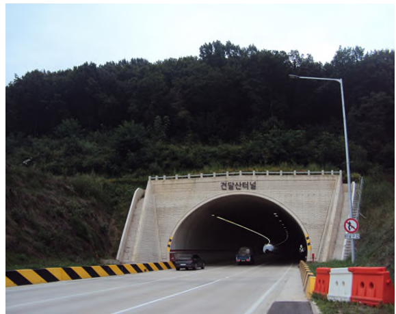
3공구 견달산터널(서울) 종점부
