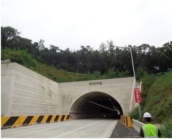
1공구 성라산터널(문산) 시점부
